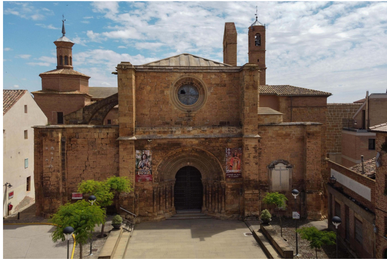
Fachada del Monasterio de Fitero, epicentro patrimonial del casco urbano de la localidad.
